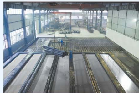
钢管酸洗 Pickling
